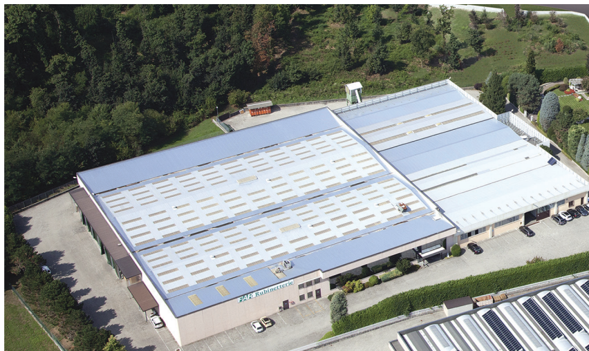
FAR - Stabilimento di Gozzano (NO)
